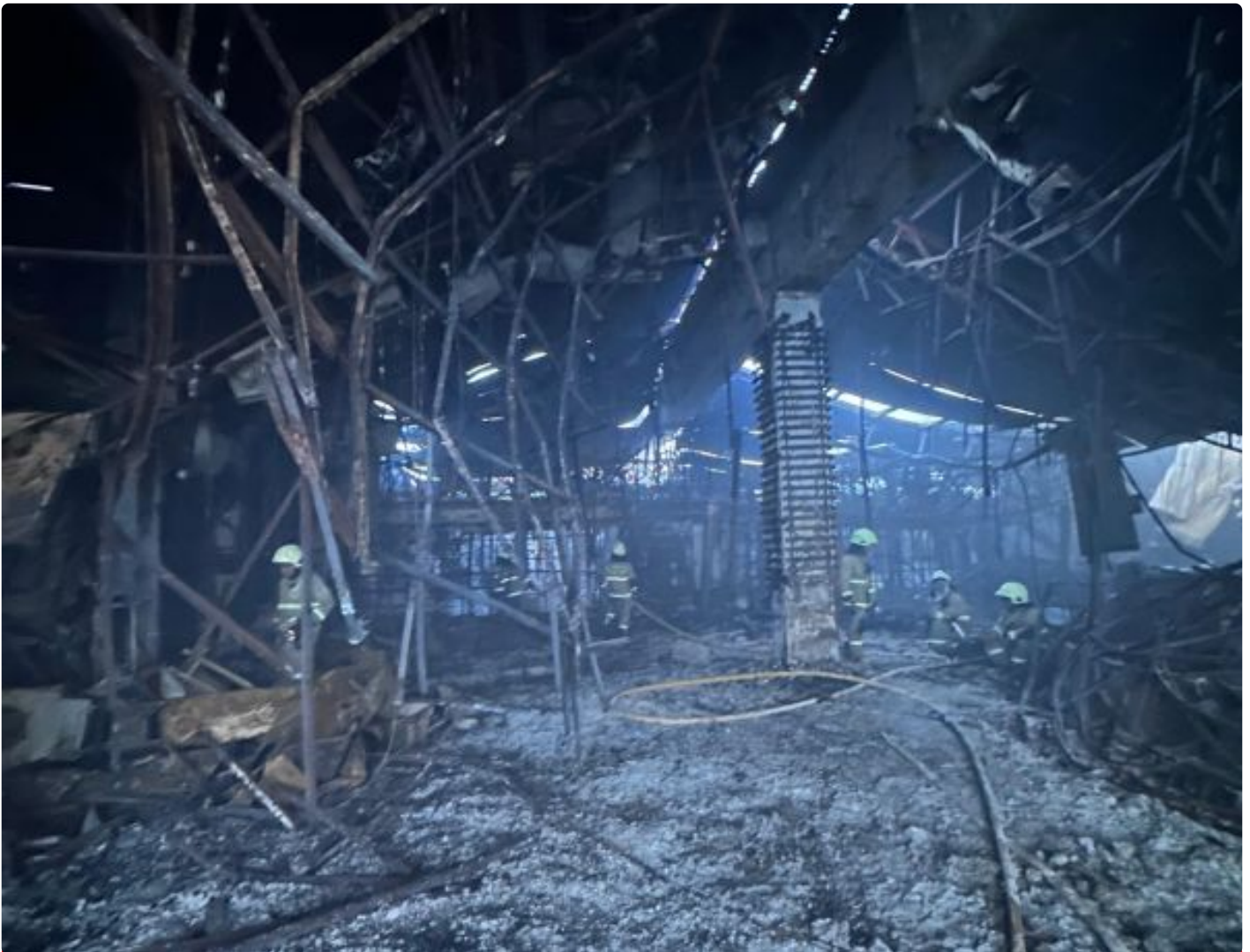
Glodok Plaza yang Hangus Terbakar
